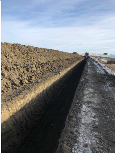
1. Ditch – km 144+250 (S.E) – Jan 8, 2018
